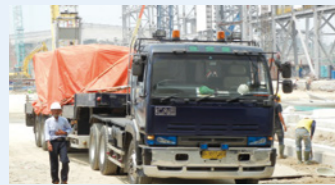
建設現場への搬入
