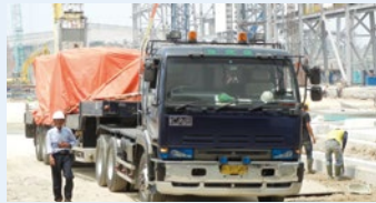
建設現場への搬入
