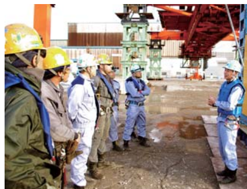
作業前のミーティングで当日の流れを最終確認。安全のため、人の動きや施工方法については入念に指示する。
